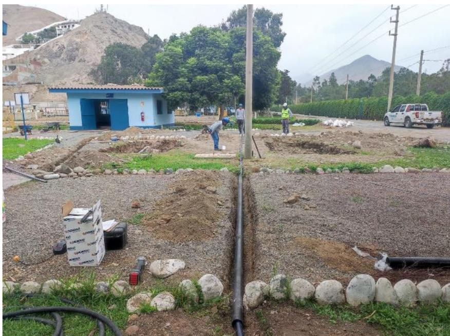
**Figura 19:** Tendido de tuberías hacia las pozas de infiltración (17.02.2023)
