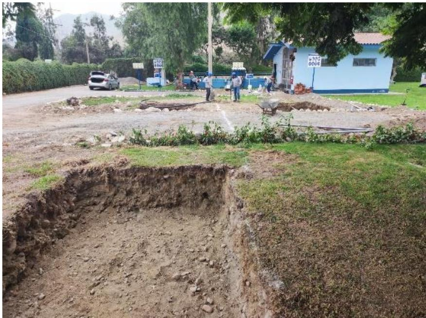
**Figura 18:** Poza de infiltración excavada, PTAR Cieneguilla (17.02.2023)
