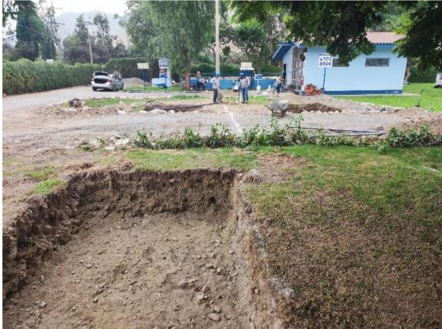
**Abbildung 18:** Ausgehobenes Infiltrationsbecken, Kläranlage Cieneguilla (17.02.2023)
