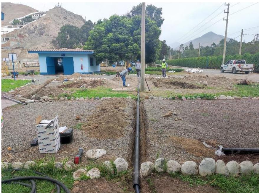
**Abbildung 19:** Verlegen der Rohrleitungen zu den Infiltrationsbecken (17.02.2023)
